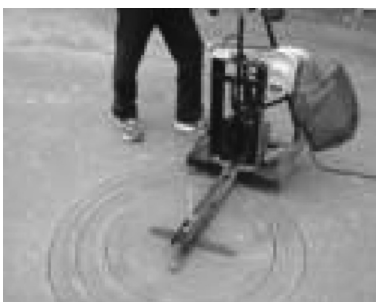
写真-1 丸穴切断作業
